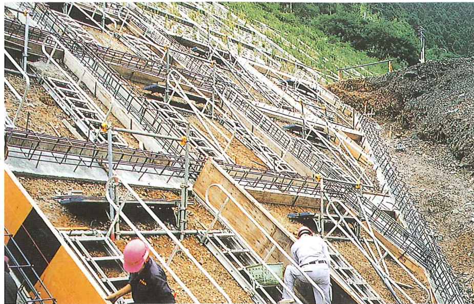
護岸工事用昇降階段として…
