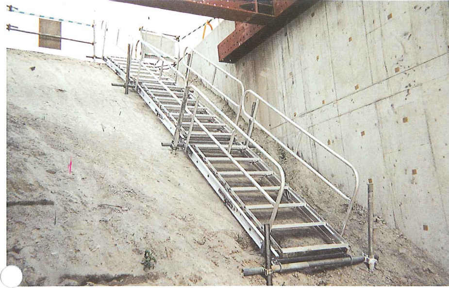
地中梁通路用昇降階段として…
