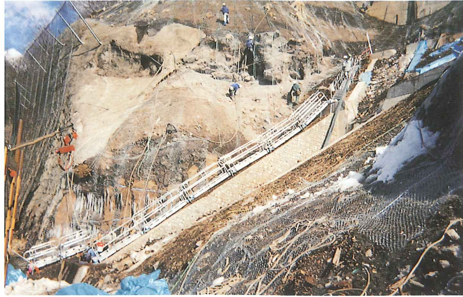
法面用作業現場の足場として…
