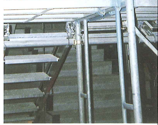
階段部補修工事用階段として…
