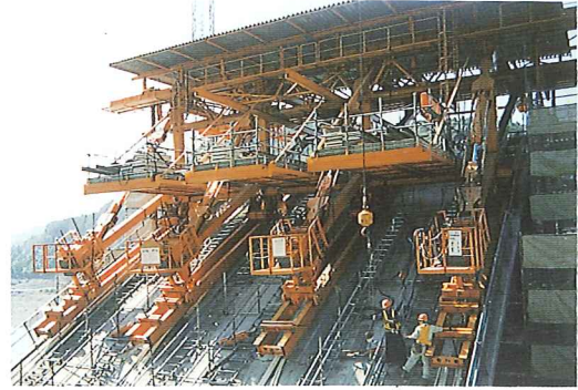
アーチ橋現場
