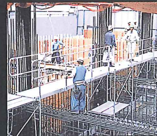
両サイドの枠組足場のパイプに ライトブリッジのフックを掛けて 安全通路が出来上がります。
