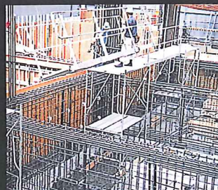
島と島間にライトブリッジを レッカー(クレーン)で降ろす。
