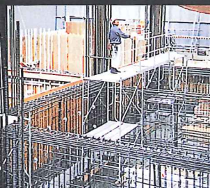
枠組足場で島を作る。
