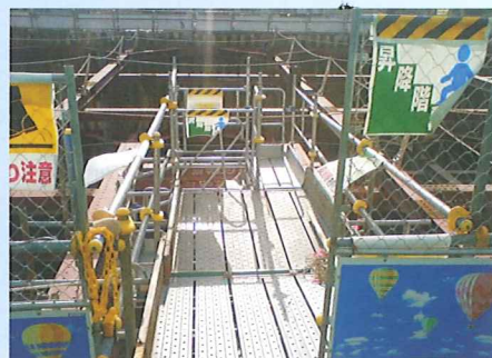
↑ 昇降口の施工例③
