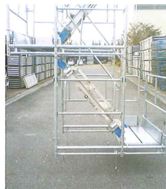
4、アルミ階段 階段手すりの設置。
