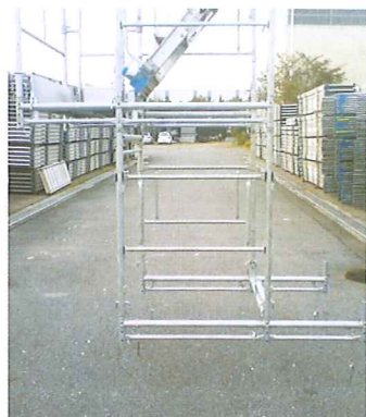
2、サイドフレーム サイドビームの設置。
