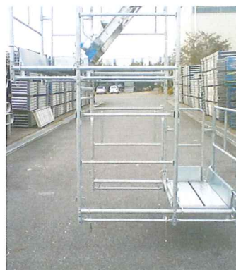
3、布板、幅木 エンドフレーム コーナー止めの設置。
