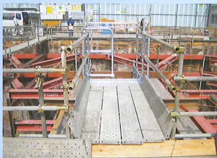
↑ 昇降口の施工例②
