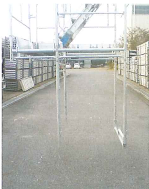
1、エンドフレーム ヘッドフレームの設置。
